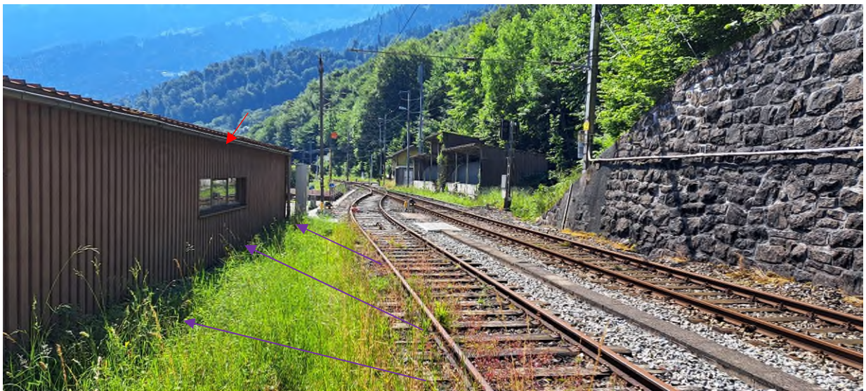
Abb. 10: Südöstlich der Laderampe fällt das Terrain vom Bahntrassee gegen einen Schuppen (roter Pfeil) und einen asphaltierten Platz ab. Die Fliessrichtung von Oberflächenwasser und allfälligem Schlamm ist mit violetten Pfeilen dargestellt.
