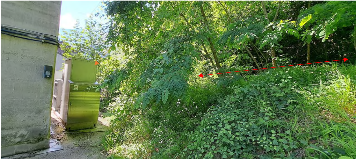
Abb. 11: Auf dem BLS-Tunnel befindet sich am Hangfuss eine rund 5 m breite Verflachung (roter Pfeil) vor den Gebäuden der Gipsfabrik sowie elektrischen Anlagen der Swisscom (oranger Pfeil). Sie weist eine Bermenwirkung auf.
