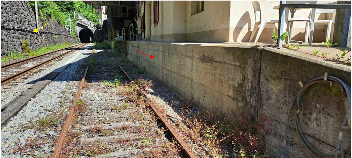
Abb. 9: Blick auf den zentralen Bereich, wo der konkave Hang auf eine rund 4 m hohe Stützmauer fusst (links im Bild, gelber Pfeil). Rechts im Bild ist die 1.2 – 1.5 m hohe Laderampe (roter Pfeil), an welche die Gebäude der Gipsfabrik anschliessen, zu erkennen. Durch die Geleise wird ein «Rückhalteraum» von 8 m Breite gebildet.
