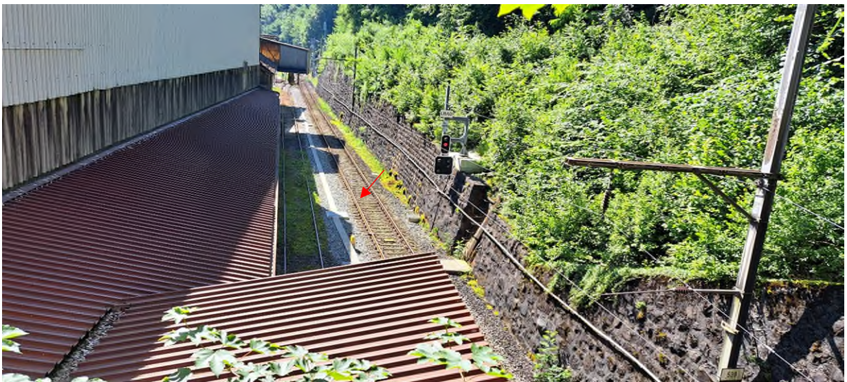
Abb. 8: Am Hangfuss befindet sich das Bahntrasse (roter Pfeil, Parzelle 817). Es weist eine Breite von rund 8 m auf.
