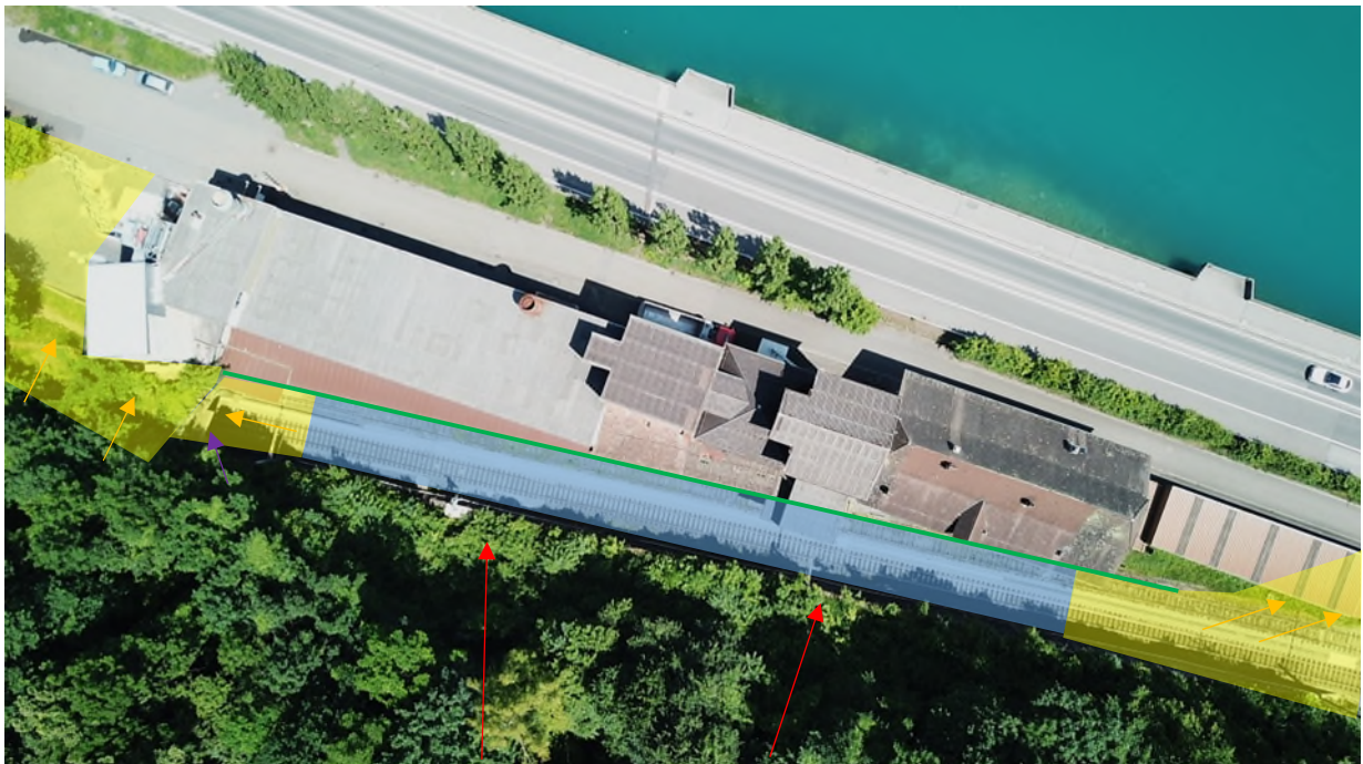
Abb. 14: Blick von oben auf die Gebäude der Gipsfabrik. Rote Pfeile: möglicher Oberflächenabfluss im konkaven Hang, blau schraffierte Fläche: Ablagerungsbereich von ausgeschwemmtem Erdmaterial und kleineren Hangmuren auf dem Bahntrasse, gelbe Pfeile und Flächen: Ausfliessen von Oberflächenwasser oder dünnflüssigem Schlamm, violetter Pfeil: Tunnelportal, grüne Linie: Laderampe.
