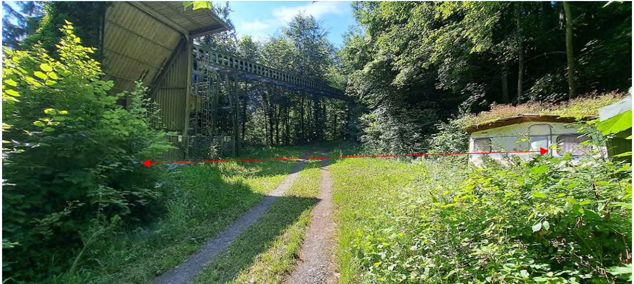
Abb. 5: Im nordwestlichen Bereich des Untersuchungsperimeters verbreitert sich die Forststrasse zu einer rund 15 m breiten Wendeplatte (roter Pfeil). In diesem Bereich befinden sich auch die Installationen des nördlichen Förderbands der Gipsproduktion.
